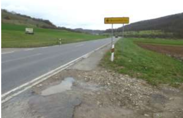
Abb. 11: Südliche Böschung der L1045 im Norden des Plangebiets
