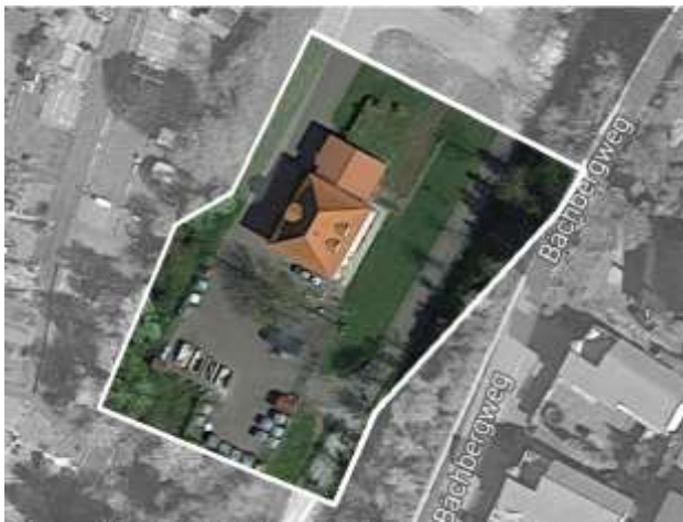
Abb. 25: Lage des Plangebiets (farbig unterlegt) im Umfeld des ehemaligen Bahnhofgebäudes
