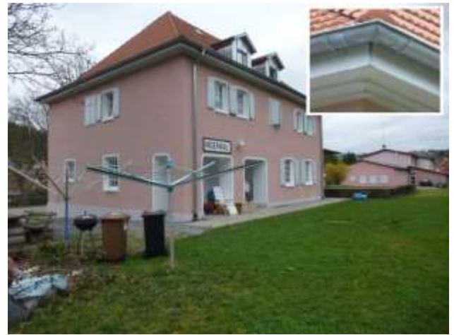
Abb. 26: Ehemaliges Bahnhofgebäude ohne tierökologisch relevante Nischen und Spalten
